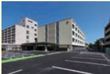
新病棟(B棟)竣工(平成25年)
