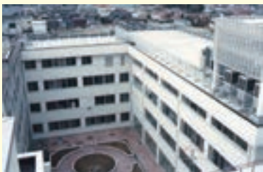
増改築工事完成(平成元年)
